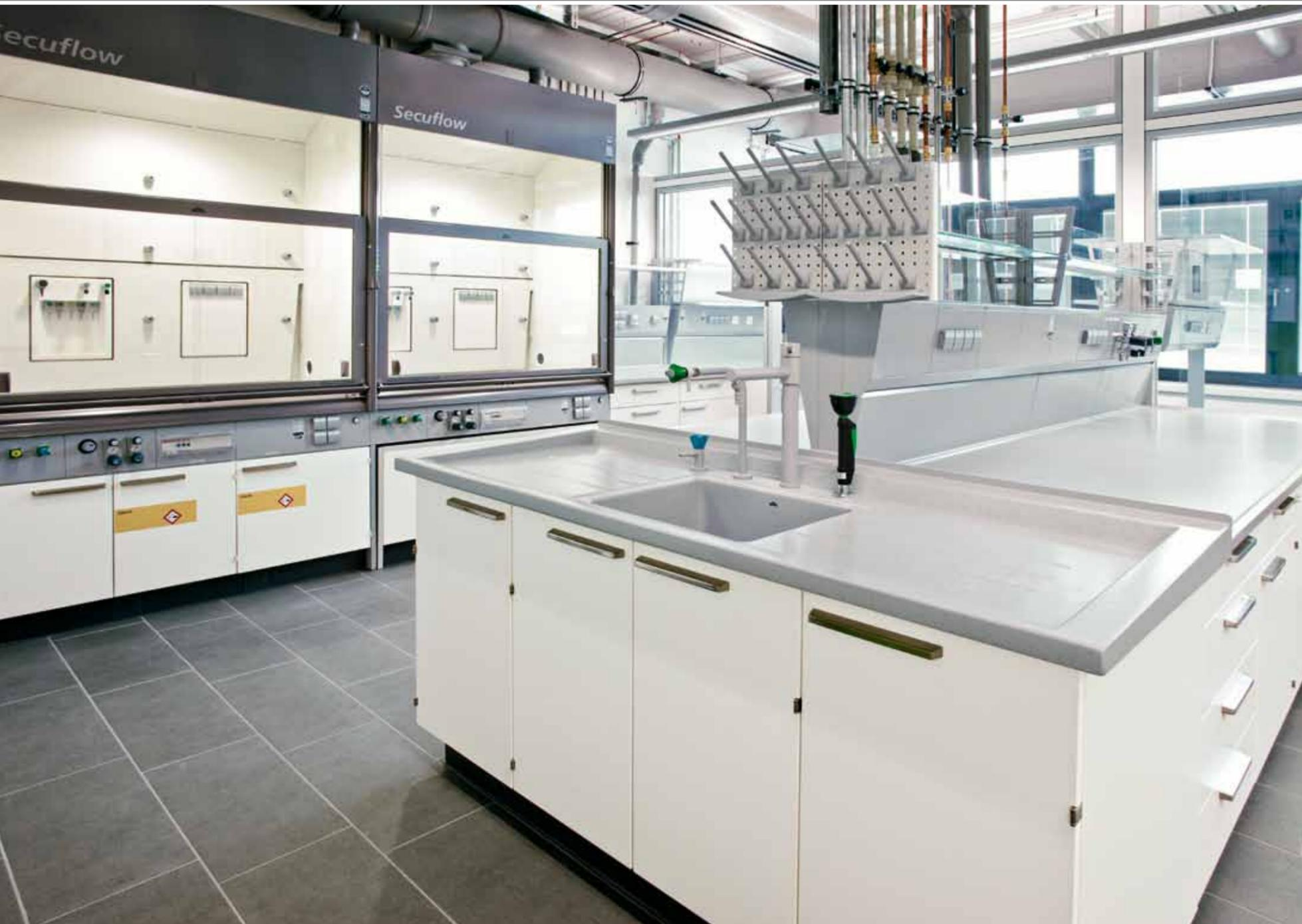
**Luogo:** Paderborn, Germania · **Area laboratorio:** ca. 2.500 m<sup>2</sup> · **Tipo di laboratorio:** Laboratori chimici · **Dotazione:** Cappe chimiche da banco Secuflow con regolatore dell'aria viziata Air-flow Controller 3 e controllore del saliscendi scorrevole · Banchi a parete e centrali · **Particolarità:** Ventilazione del laboratorio, inclusa regolazione dell'alimentazione e scarico dell'aria · Allacciamento alla tecnica dell'edificio via Modbus
